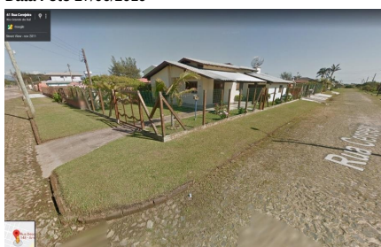
Representação Fachada Descrição fotos Google Data Foto 28/06/2019
