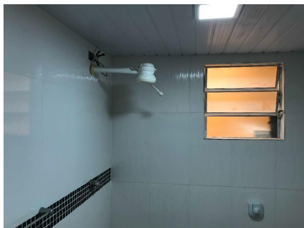
Representação Banheiro social Descrição 1 Data Foto 04/08/2021
