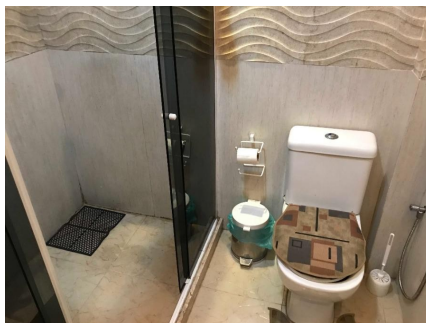
Representação Banheiro social Descrição 2 Data Foto 04/08/2021
